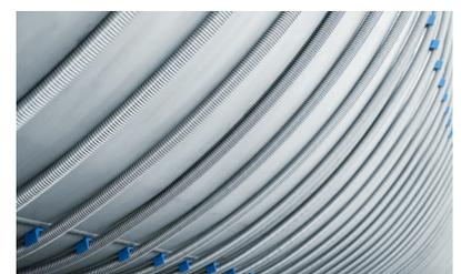
Am großen 50m<sup>3</sup> Behälter werden knapp 400 Meter Begleitheizungsschlauch in DN 20 verbaut. Dies entspricht einer Oberfläche von ca. 50 m<sup>2</sup>.
