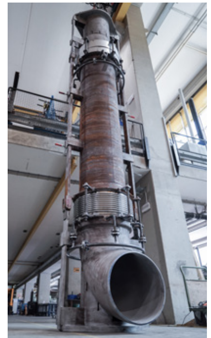
8 米长, 3.2 吨重 – 正在维护中的横向膨胀节
