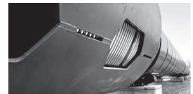
Bild 12.13 Druckentlasteter Axial-Kompensator, Prinzip Ringraum, in Fernwärmetransportleitung DN 1000
