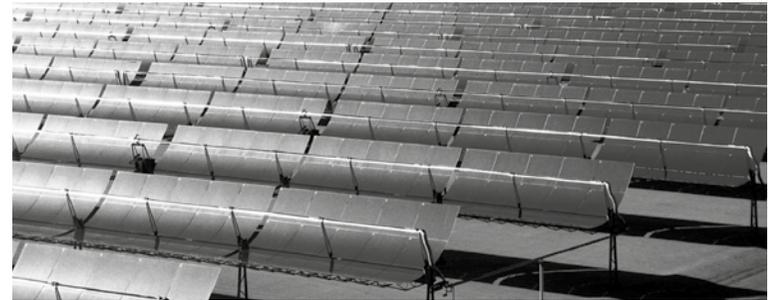
Die Solarthermie gewinnt zur Energiegewinnung zunehmend an Bedeutung; sowohl im industriellen Maßstab in Solarkraftwerken als auch in der Gebäudetechnik. Die Kombination von Werkstoffen mit unterschiedlichen Wärmeausdehnungskoeffizienten führt bei allen solarthermischen Anlagen zu thermischen Dehnungen, die durch Metallbälge ausgeglichen werden müssen.
