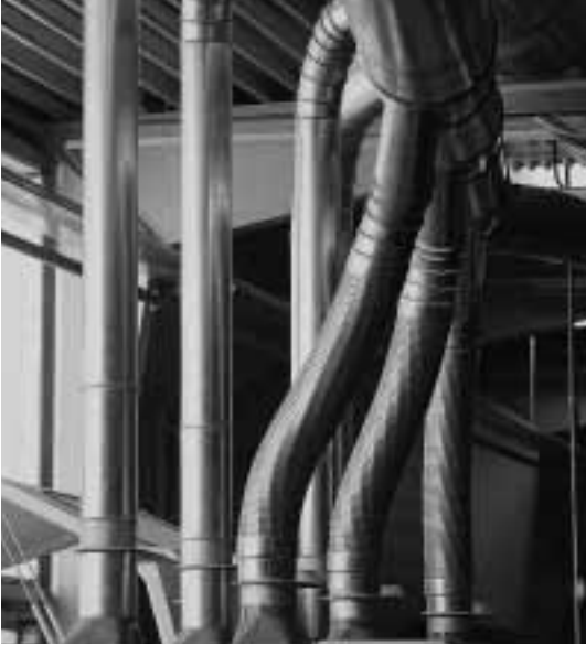
Gaine d'aspiration dans une entreprise spécialisée dans le travail du bois
