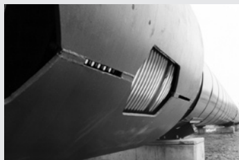
Рис. 12.13 Гидростатически уравновешенный осевой компенсатор; принцип кольцевой камеры, для теплоцентралей Ду 1000
