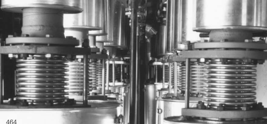
Установка компенса- тора
