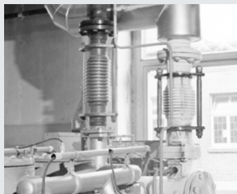
Рис. 13.13 Боковой компенсатор со стяжными болтами на вибрирующем агрегате
