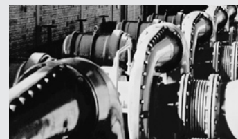
Рис. 8.16 Осевой компенсатор в качестве демонтируемой детали.
