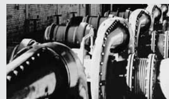
Rysunek 8.16 Kompensator osiowy w charakterze elementu (de)montażowego.
