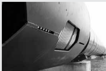
Rysunek 12.13 Zasada działania odciażonego kompensatora osiowego — pierścieni kołowy. Zastosowanie w instalacji grzewczej DN 1000.
