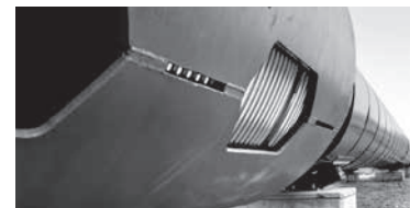
Bild 12.13 Druckentlasteter Axial-Kompensator, Prinzip Ringraum, in Fernwärmetransportleitung DN 1000
